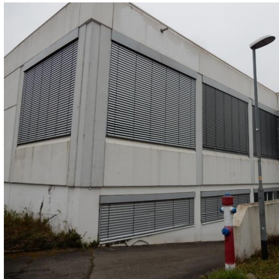
Abb. 2: Die Attika-Verkleidung und Jalousien am alten Fabrikgebäude direkt angrenzend zum Plangebiet bieten Quartierpotentiale für gebäudebewohnende Fledermäuse.
